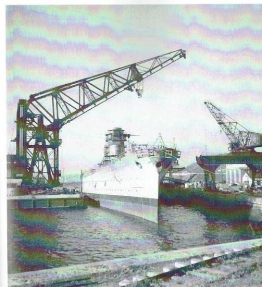
Le Richelieu en achèvement à flot, avec sur son étrave une grue flottante de 250 tonnes.
