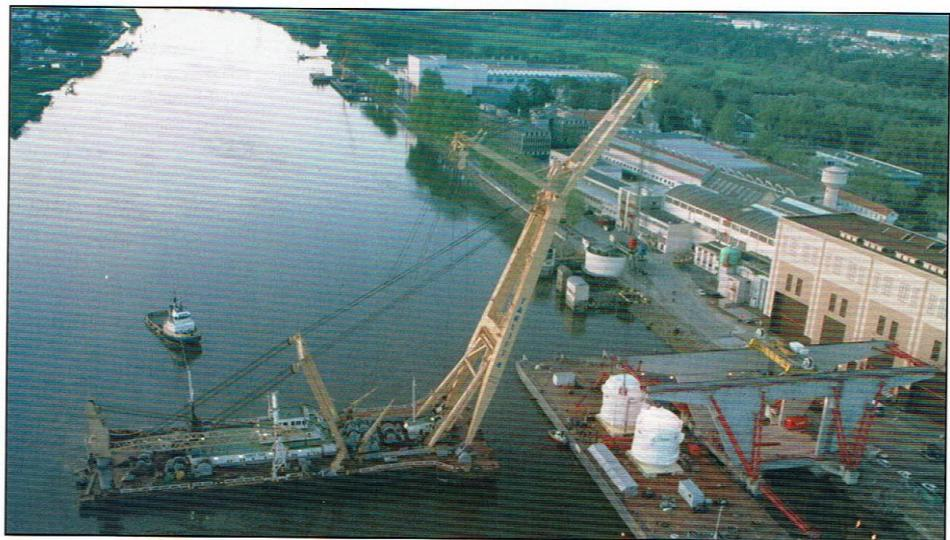
• La grue, en travers de la Loire, dépose la de la deuxième enceinte sur la barge Dino II •
