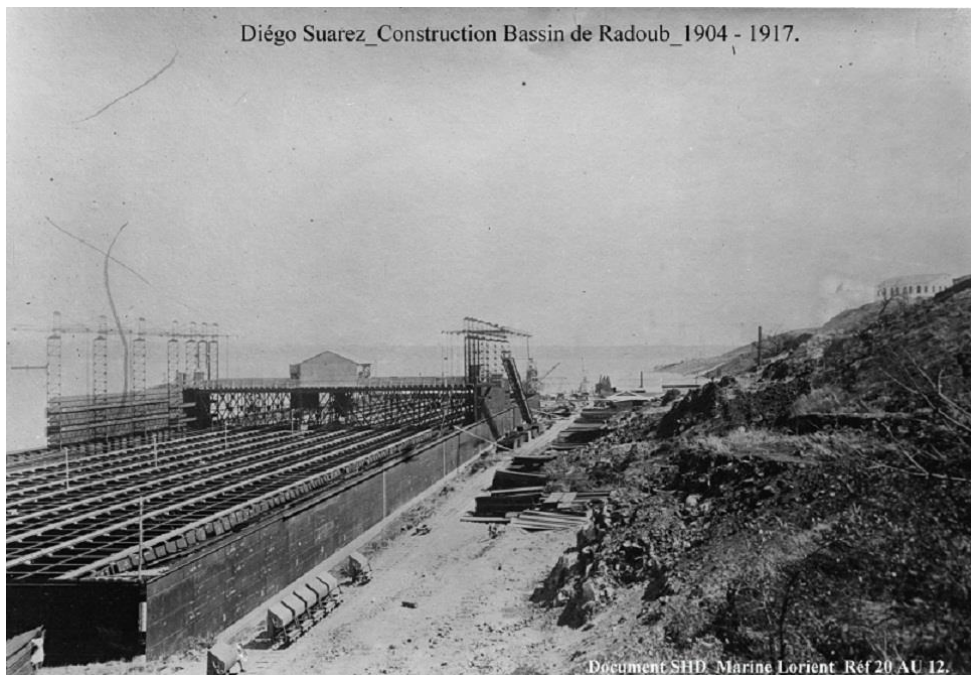
Photo 15 : Construction du caisson métallique dans un bassin asséché (Archives SHD
