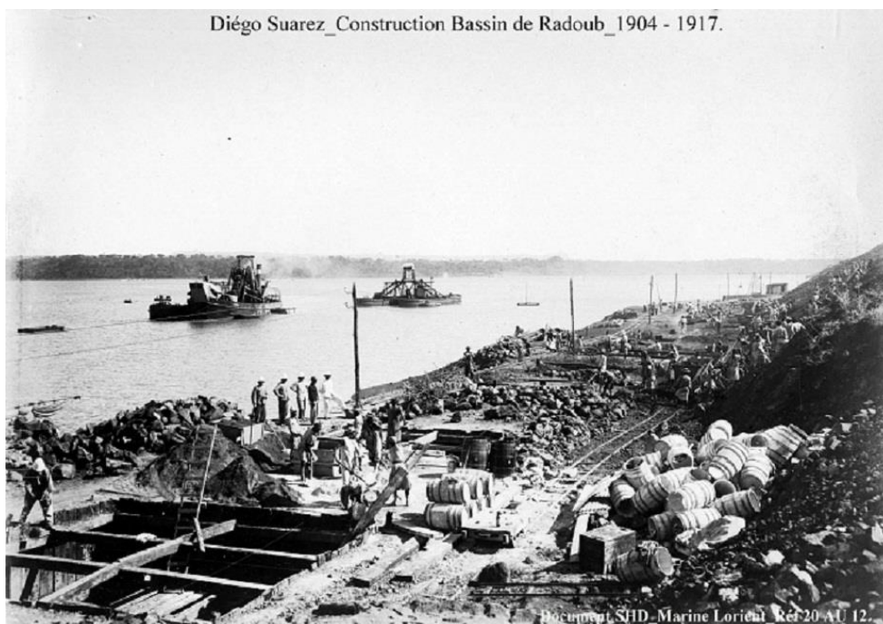
Photo 6 : Travaux de dragage et puits (Archives SHD Lorient)
