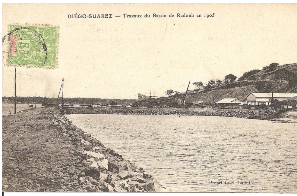
Photo 9 : Travaux du Bassin de Radoub en 1905 (CPA Edition Laudié) (Le bassin pour la construction du caisson métallique est fermé)
