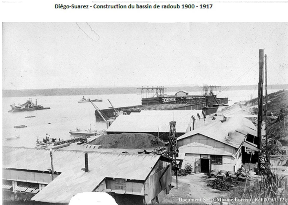
Photo 23 : Construction à flot des caissons latéraux et des bajoyers (Archives SHD Lorient)
