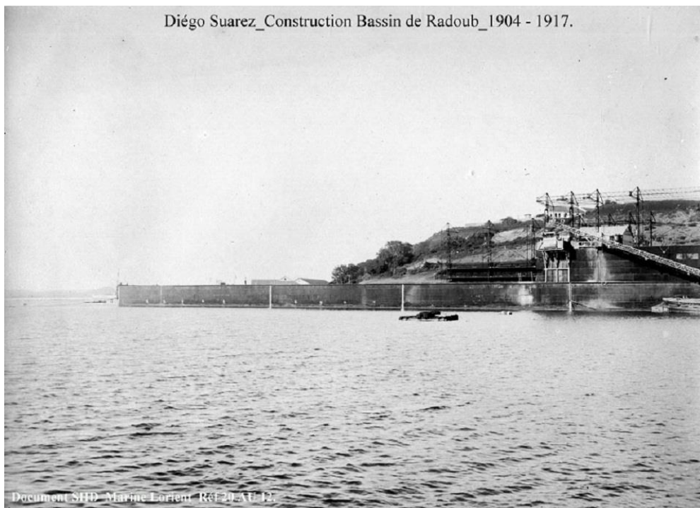
Photo 24 : Construction à flot des caissons latéraux et des bajoyers (Archives SHD Lorient)
