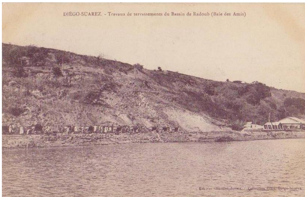
Photo 5 : Travaux de terrassement du bassin de radoub (Baie des amis) (CPA Edition Charifou) (Début des travaux)
