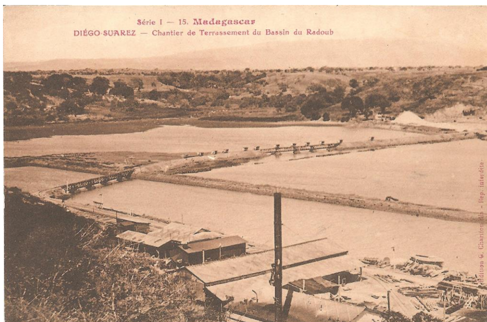
Photo 7 : Chantier de terrassement du bassin de Radoub (CPA Edition Charifou)
