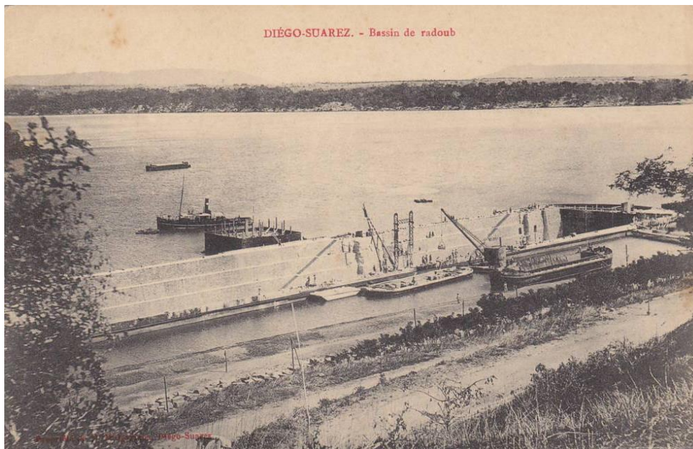
Photo 28 : Bassin de radoub (CPA Edition Charpentier) Achèvement de la maçonnerie, tablettes, escaliers, feuillures, aqueducs de remplissage et d'épuisement, usine d'épuisement, etc...Le batardeau métallique lesté était encore en place.
