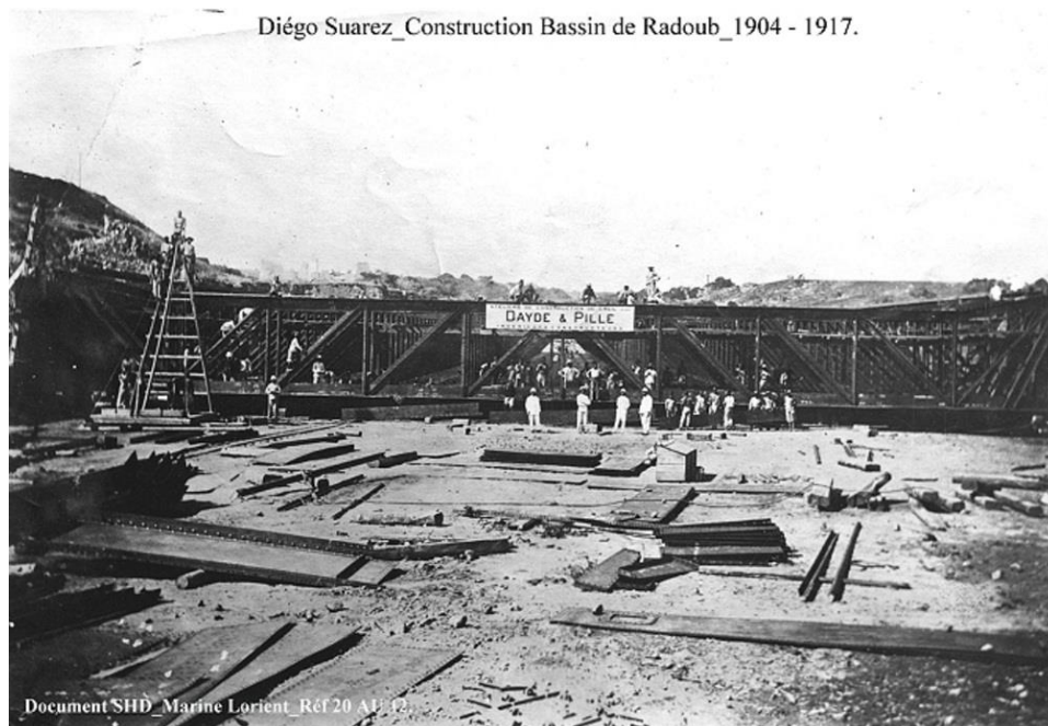
Photo 12 : Construction du caisson métallique dans un bassin asséché (Archives SHD Lorient)
