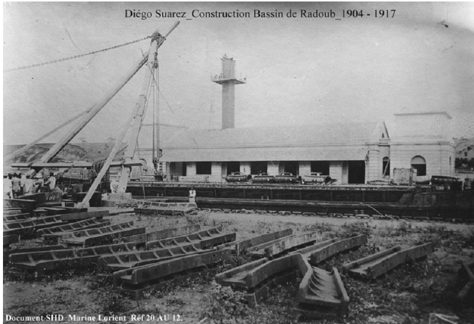
Photo 37 : Bâtiment de l'usine d'épuisement (Archives SHD Lorient) (Les supports de tins en fonte sont posés sur le terre plein en attente d'être descendus dans le bassin)
