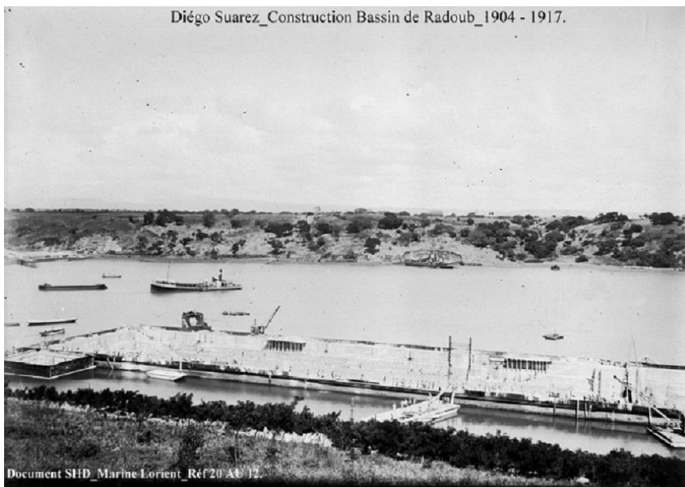
Photo 26 : Construction des maçonneries en pierres de taille (Archives SHD Lorient)
