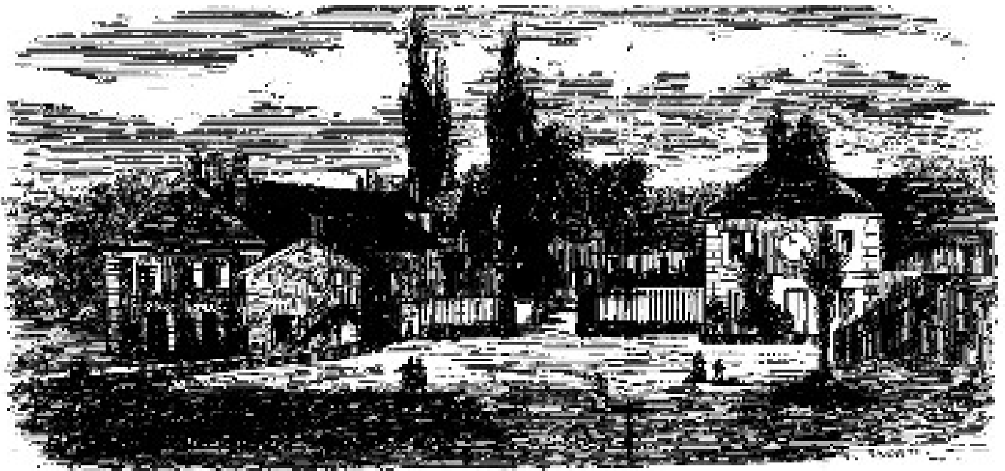
Travaux de la Clousance, en entrée principale du groupe central
